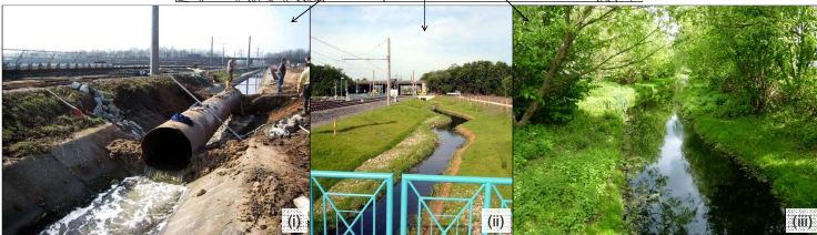
Abb. 1: oben: Lage der drei Probestellen oberhalb, innerhalb und unterhalb der Renaturierung. unten: Situation des renaturierten Teilstückes (ps_02) (i) während, (ii) nach Abschluss und (iii) 12 Jahre nach der gewässerbaulichen Maßnahme.
